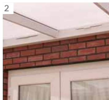
2 Elevation Trickle Ventilation (wallplate)
