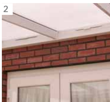
2 Elevation Trickle Ventilation (wallplate)
